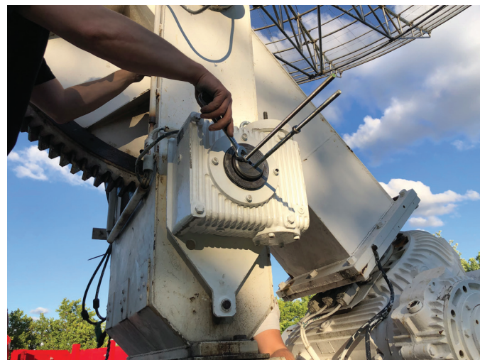
3. Remontage du moteur après rénovation.
