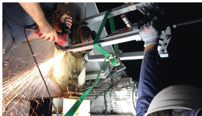
2. Extraction du réducteur et du moteur de déclinaison.
